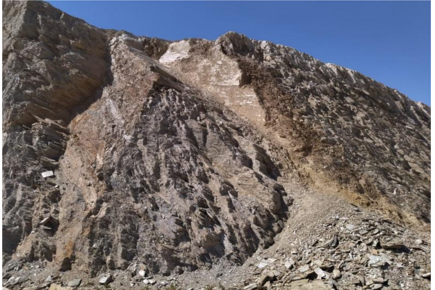
GLISSEMENT DE TERRAIN AU NIVEAU DE LA SECTION 11
